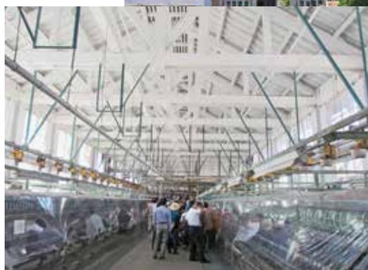
さらに、繭から生糸を取る「操糸所」の小屋組には「トラス構造」という従来の日本にない建築工法を採用し建物内部は中央に柱のない広い空間が保たれています。
